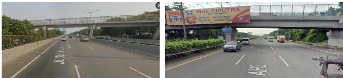
2a. Jalan Tol Jakarta-Bogor (Cibubur) 2b. Jalan tol Jakarta-Tangerang (Kebon Jeruk)
